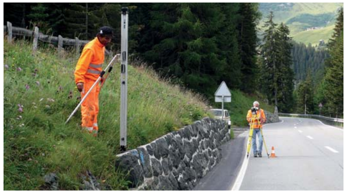
Bild 9. Nivellement im Rutschhang Natons, Stauanlage Marmorera.
