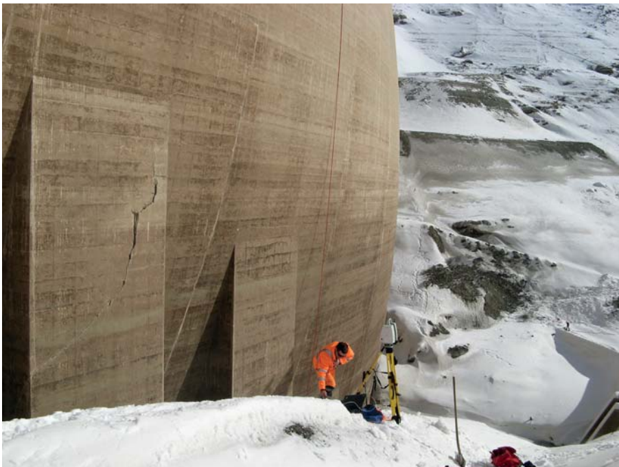
Bild 10. Einsatz des 3D-Laserscanners bei der Kartierung von Rissen der Staumauer Valle di Lei.
