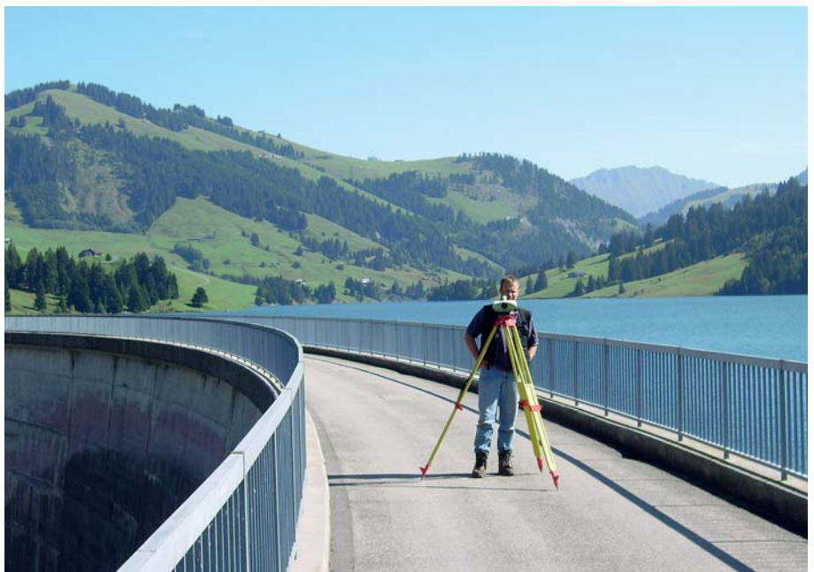
Bild 1. Präzisionsnivellment über die Mauerkrone der Stauanlage Hongrin.
