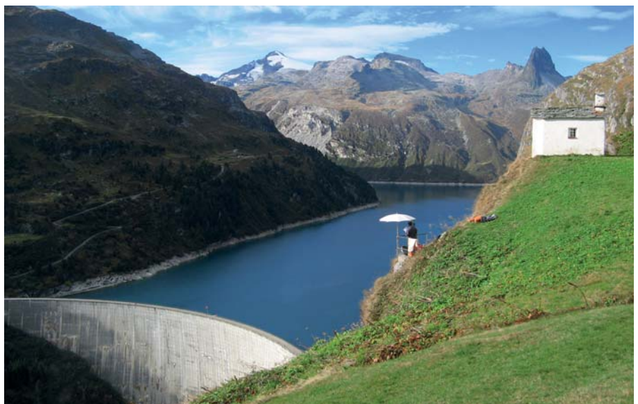
Bild 3. Messungen im Trilaterationsnetz der Staumauer Zervreila.
