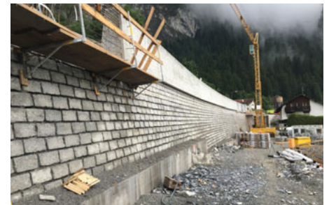
Neubau Brücke Val Turnigel, Neue steinverkleidete Schwergewichtsmauer
